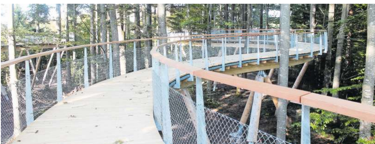
Das Drahtgeflecht wurde bewusst nicht bis zum Handlauf gezogen: wegen des Ausblicks für Kinder und Rollstuhlfahrer.
