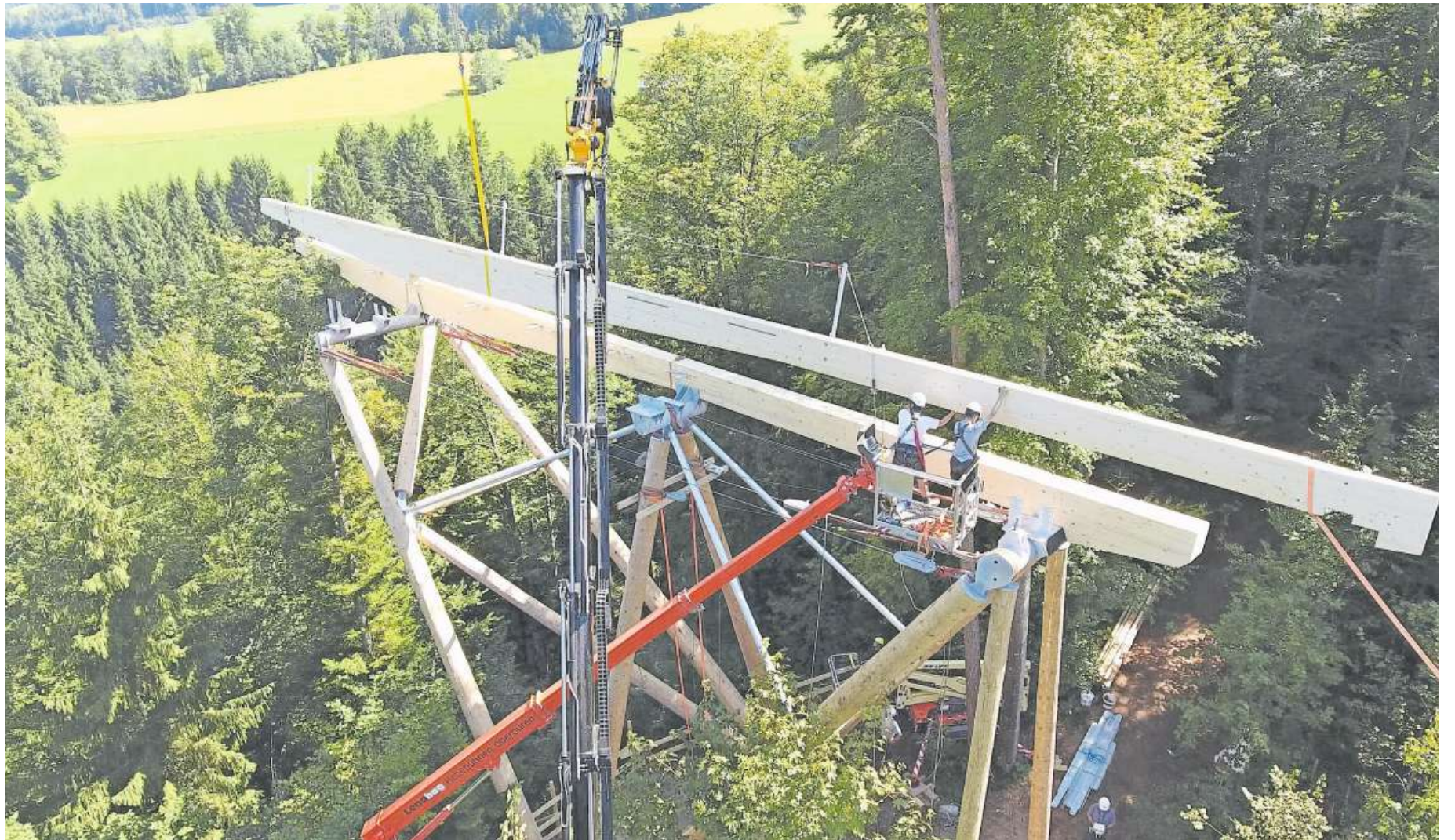
Schwindelanfälle verboten: Zimmerleute bei ihrer kniffligen Arbeit am Baumwipfelpfad. Stellenweise arbeiten sie 18 Meter über dem Boden.
