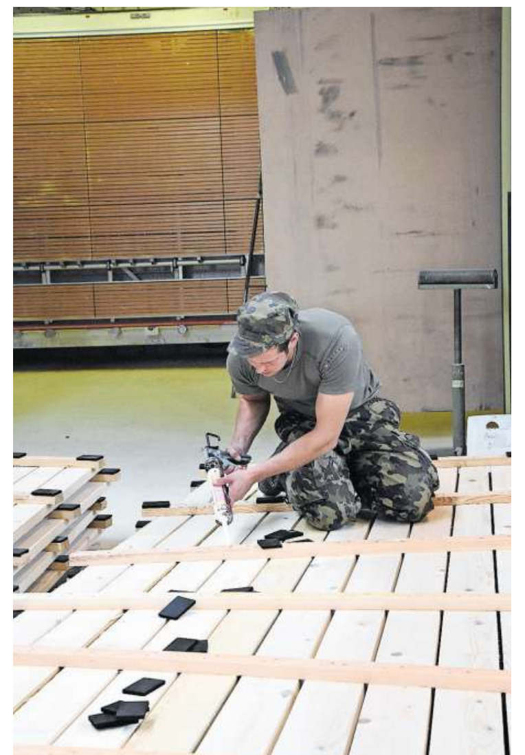
Als Abstandhalter werden Gummipplatten auf die Gehoste geklebt.
