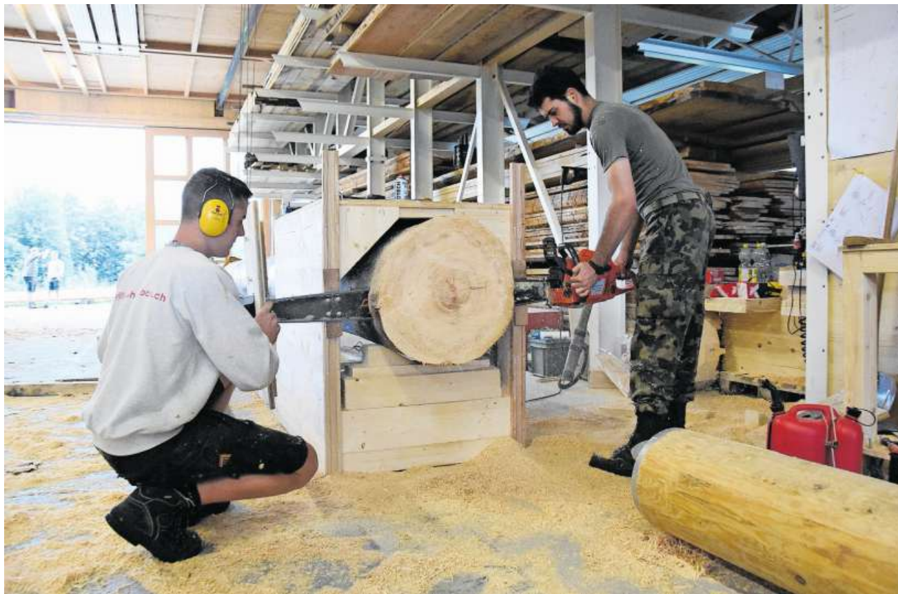
90 Stützen werden auf die richtige Länge – die längste misst 15 Meter – zugeschnitten.
